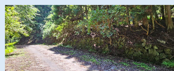
昭和10年頃に建設された道路と石垣
